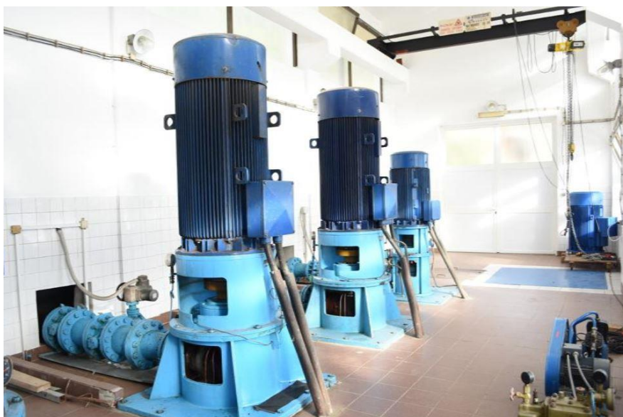
Slika 7 Nova crpna stanica na Vranskom jezeru
